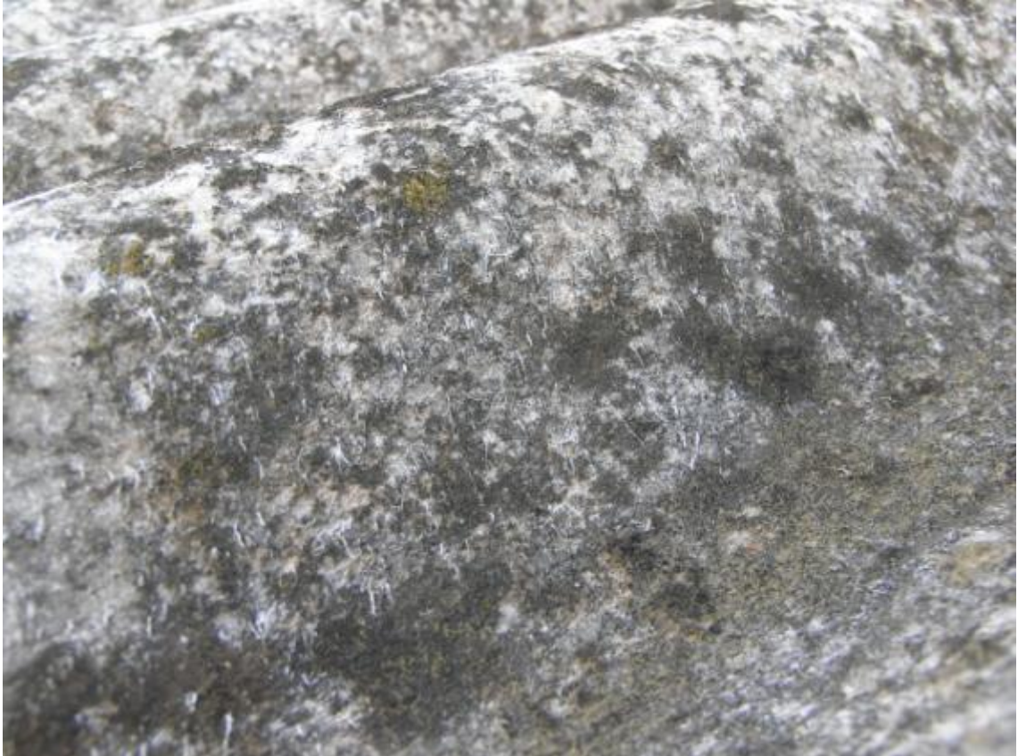
Detall d'unes plaques de fibrociment malmeses per les inclemències atmosfèriques
